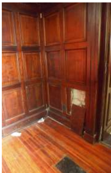
Recinto: deterioro en pisos, alfombras y bancas y pérdida de valor patrimonial en las paredes de toda la sala, incluida las pilastras talladas y los frisos de la Galería de los escudos.
