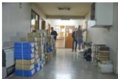
Oficinas con conexiones eléctricas de alto riesgo para el personal. Cajas de archivos apiladas en los pasillos de circulación. Paredes revestidas con maderas y cañerías expuestas.
