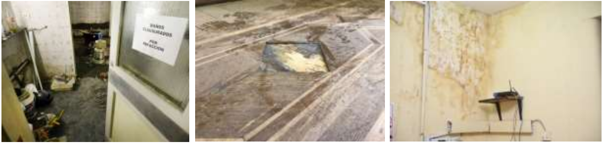
Baños con sanitarios y cañerías en desuso. Paredes con humedad. Pisos de madera rotos.
